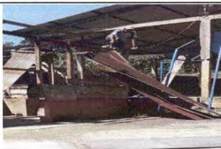
Foto 3: Sustitución de lámina por lámina troquelada Aluzin calibre 26 en cocina; sustitución de estructura de soporte de madera por metal en cocina
