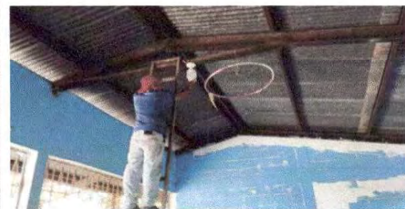
Foto 9: Sustitución de focos ahorradores, sustitución de plafoneras dentro y fuera de las aulas
