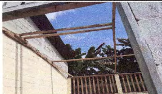
Foto 2: Sustitución de lámina por lámina troquelada Aluzin calibre 26 en aula; sustitución de estructura de soporte de madera por metal en aula
