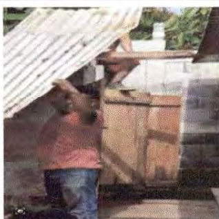
Foto1: Sustitución de lámina por lámina troquelada Aluzin calibre 26 en servicio sanitario; sustitución de estructura de soporte de madera por metal en servicio sanitario
