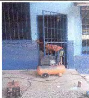
Foto 15: Fabricación e instalación de puerta de rejas en dirección del establecimiento.
