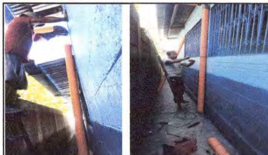
Foto 6: Sustitución e instalación de canales y tubos PVC para aguas pluviales atrás de la aulas
