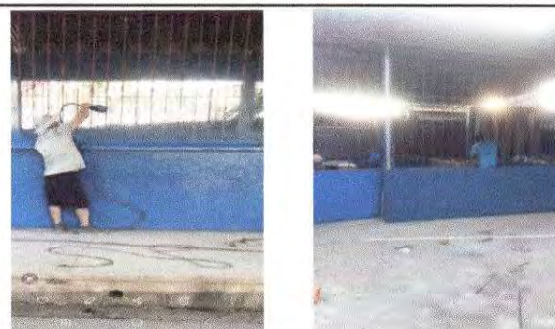
Foto 4: Mantenimiento de estructura de metal de aula y sustitución de balcón de metal a cocina
